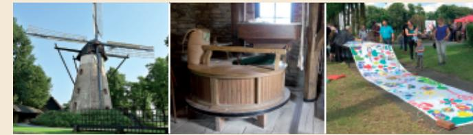
Die Kornwindmühle auf dem Ochtruper Berg ist eine der letzten im holländischen Stil errichteten Windmühlen vom Typ „Wallholländer“. Die Mühle wurde im Jahre 1848 errichtet und steht auf einem Wall, der Rumpf ist starr, und nur die Kappe mit den Flügeln wird in den Wind gedreht. Seit über 110 Jahren ist sie im Besitz der Familie Nobbenhuis und steht seit der letzten Renovierung 2015-2016 wieder imposant, voll funktionsfähig und mit beeindruckender Technik da.
