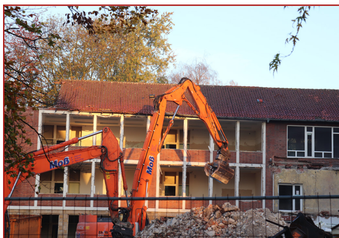
Die Abbrucharbeiten an der Pestalozzischule im Herbst 2020
