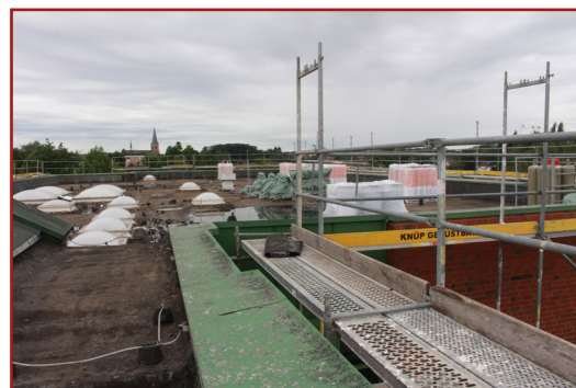
Dacharbeiten an der Hauptschule im Sommer 2020
