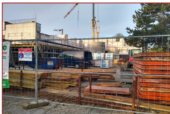
Baustelle Lambertischule in den Herbstferien 2020
