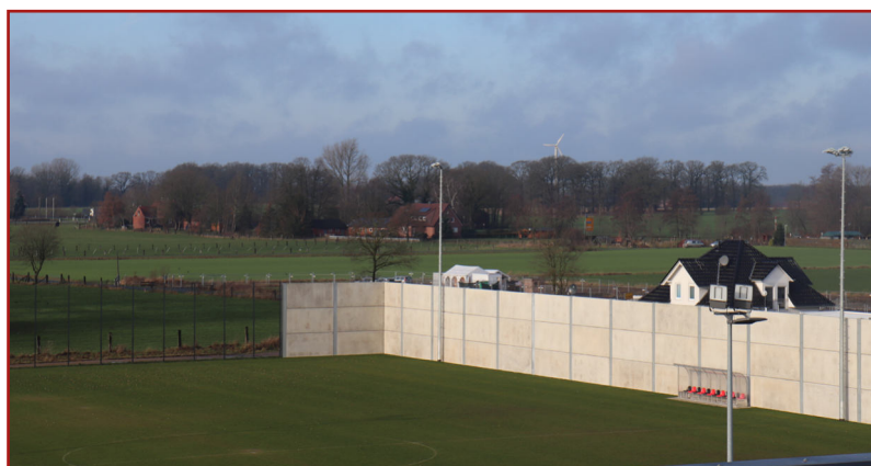
Eine Schallschutzmauer zum Wohngebiet erfüllt wichtige Zwecke.
