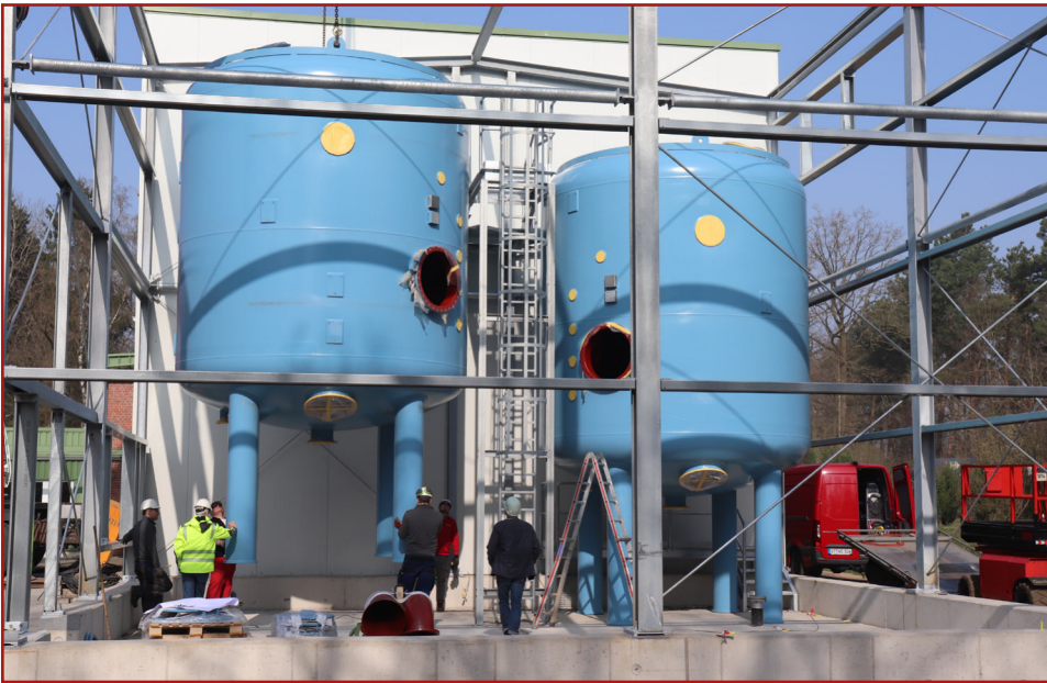
Die mächtigen Aktivkohlebehälter wurden bereits 2021 eingebaut.
