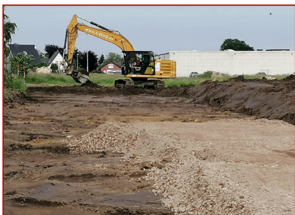
2021 rollten die Bagger für die neuen Fußballplätze hinter dem Sportwerk.
