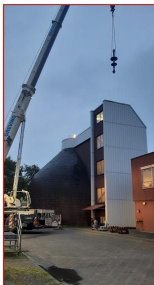
*Der Faulschlamm-Mischer hängt am Kran hoch über dem Faulturn...*
