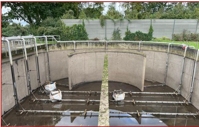
*Ausbau der alten Membranrohrbelüfter*
