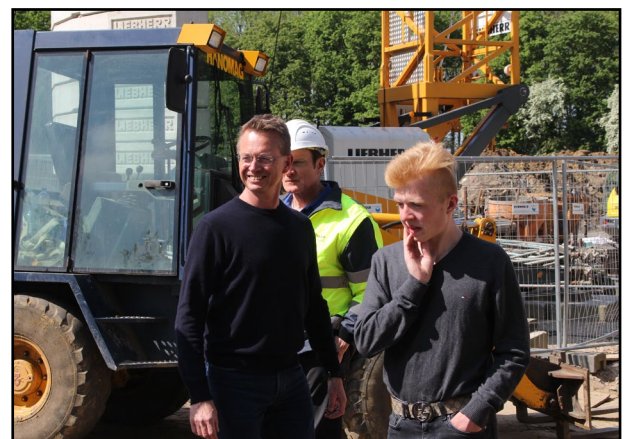
SWO-Leiter Robert Ohlemüller und Azubi Ole Herbering auf der Baustelle. Im Hintergrund: Bauleiter Norbert Storm
