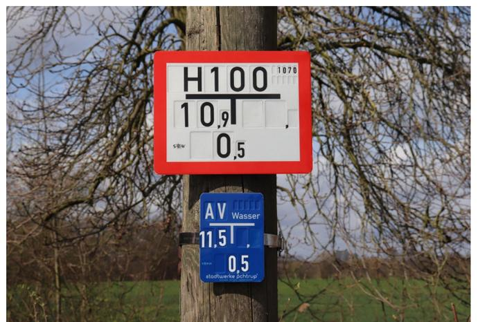
Man muss es nur zu lesen wissen: Der Ort des Hydranten, des Absperrventils und der Durchmesser der Wasserleitung sind am Hausanschluss festgehalten.
