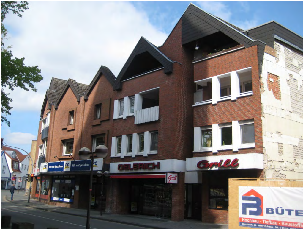
Abbildung 5: Bebauung an der Bültstraße aus den 1980er Jahren
