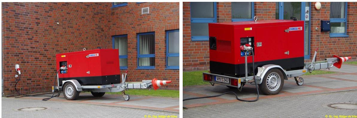
**BILD 6.2** Für ausgewählte Feuerwehrhäuser wird Noteinspeisung empfohlen. Für die Stromerzeugung werden Anhänger empfohlen, die mit Lichtmast oder -ballon ausgestattet werden sollten, um im normalen Einsatzdienst zur Ausleuchtung von Einsatzstellen verwendet werden zu können.
