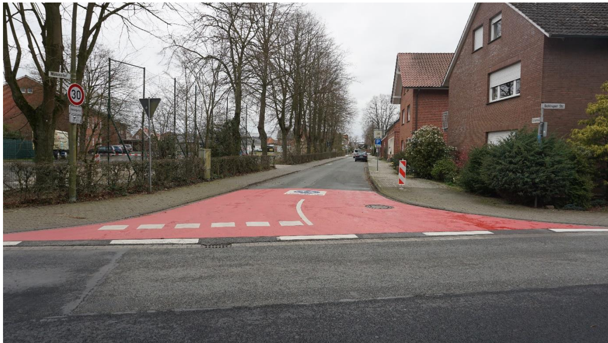
Triangel-Radweg – Metelen, Schulstraße - Ochtruper Damm
